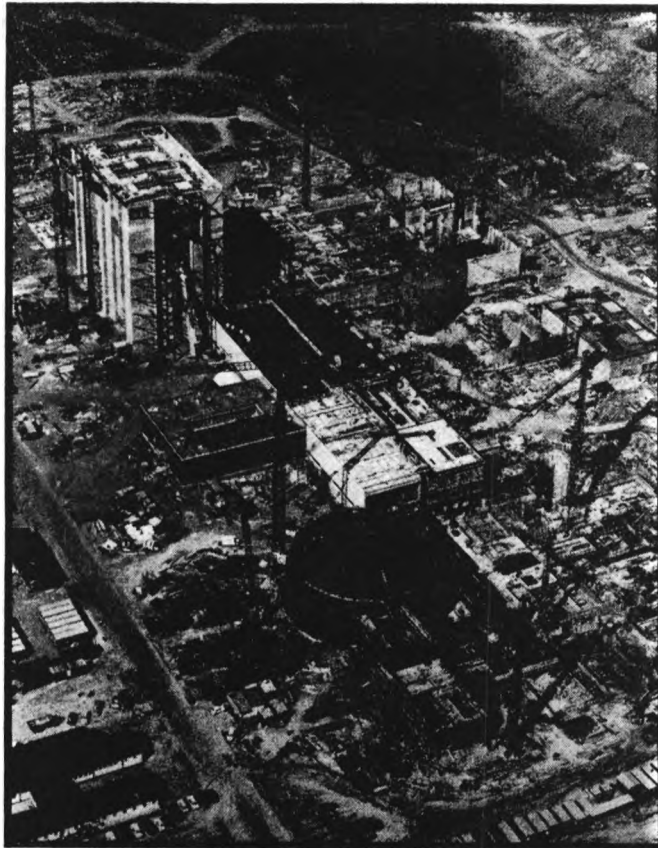
Ringhals. Vattenfalls första kommersiella kärnkraftstation. Aggregat 1 i övre vänstra hörnet på bilden får en kokarreaktor och aggregat 2 i nedre hörnet får en tryckvattenreaktor.
